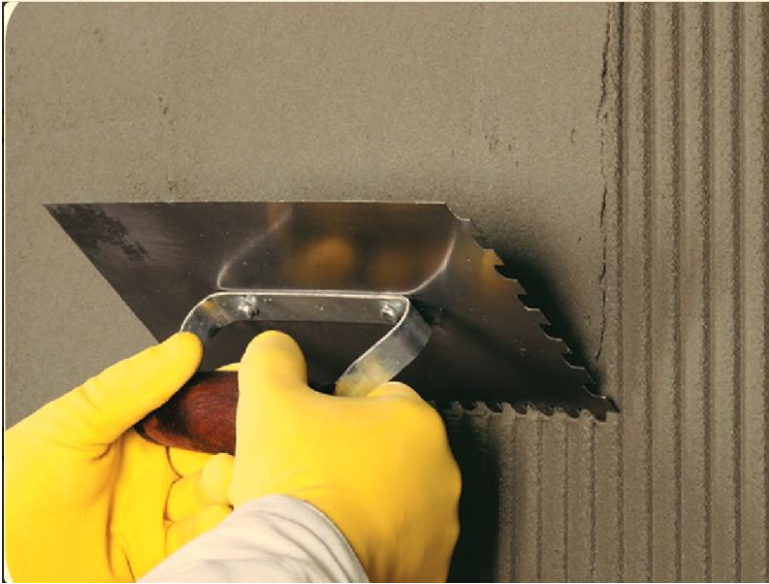
Figura 13 - Aplicação de argamassa no substrato
