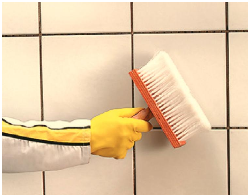
Figura 18 - Limpar a superfície da placa
