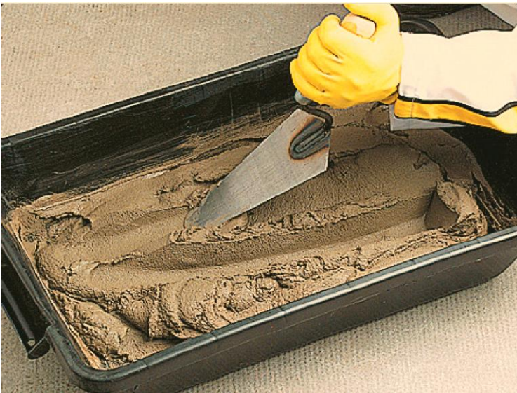
Figura 12 - Misturar a argamassa para agregar com a água
