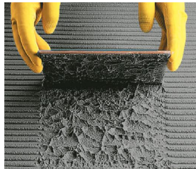
Figura 16 – Esmagamento completo dos cordões. FORMA CORRETA
