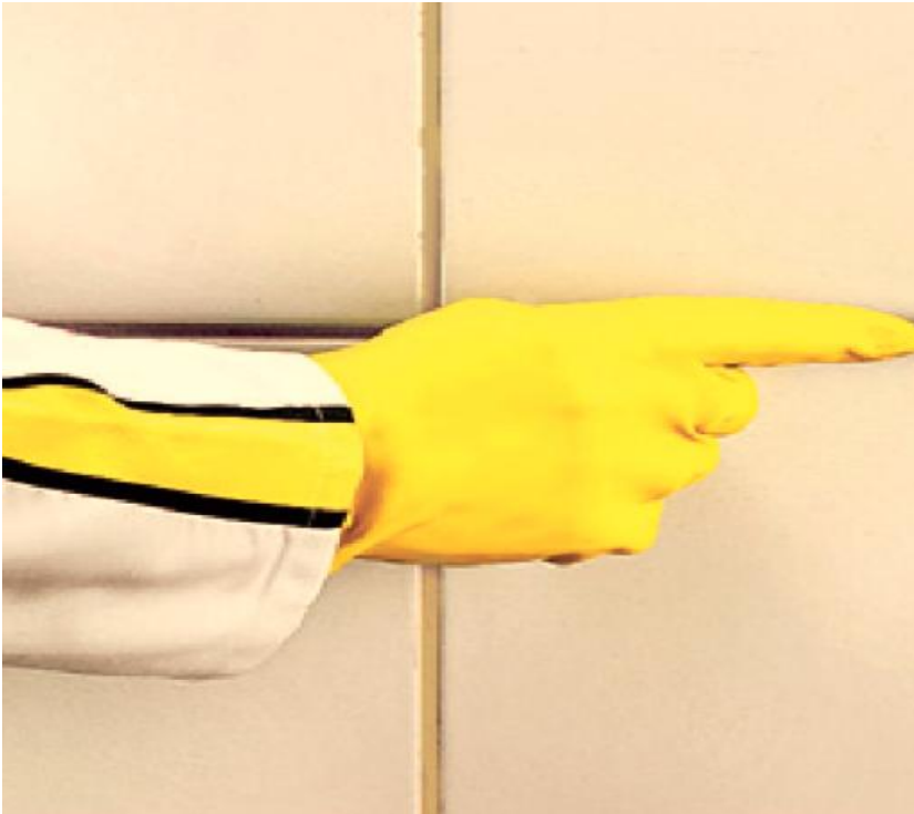
Figura 7 - Junta de assentamento
