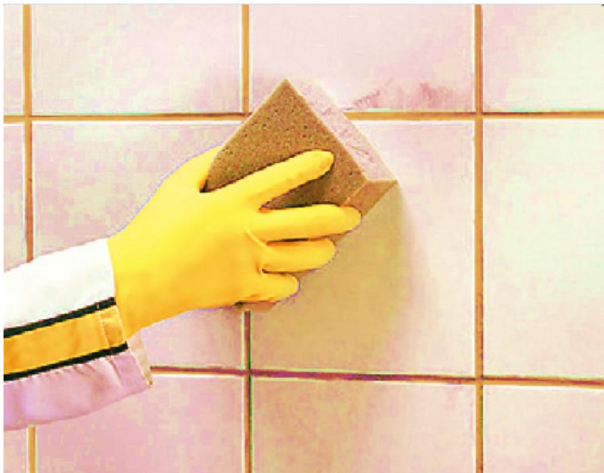
Figura 20 - Limpar o rejunte das placas com esponja úmida
