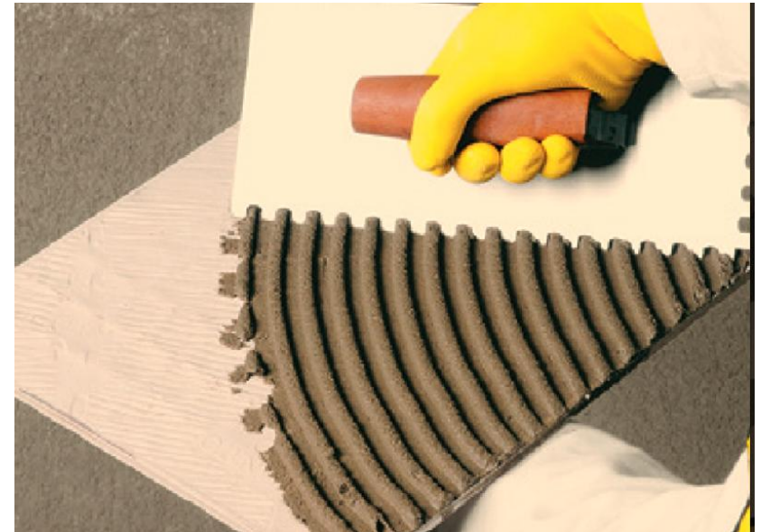
Figura 14 - Aplicação de argamassa na placa cerâmica
