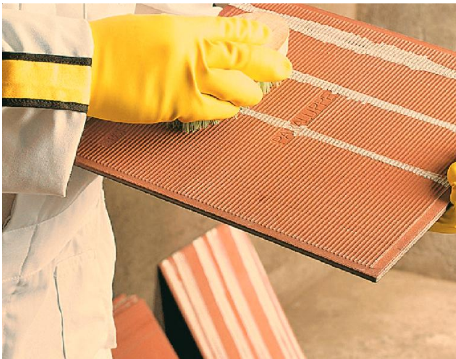
Figura 10 - Limpar a base da placa cerâmica
