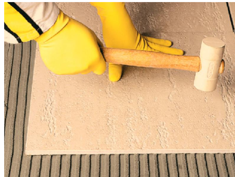
Figura 15 - Aplicação de golpes com martelo de borracha
