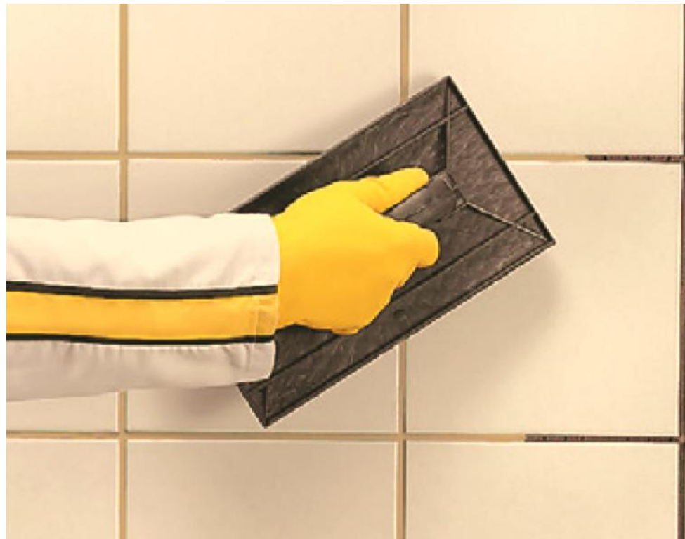
Figura 19 - Aplicação de rejunte nas placas assentadas
