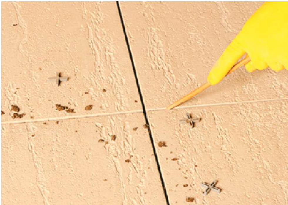
Figura 17 - Retirar excesso de argamassa nas juntas
