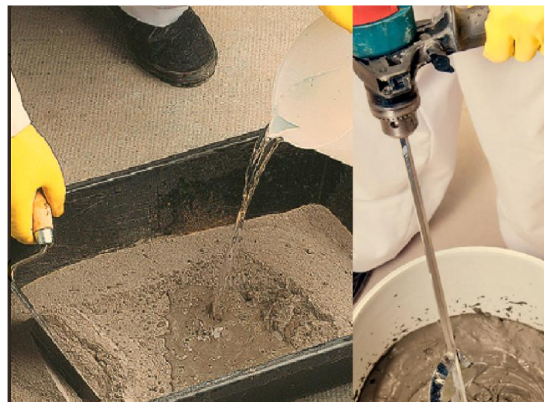
Figura 11 - Mistura da argamassa colante
